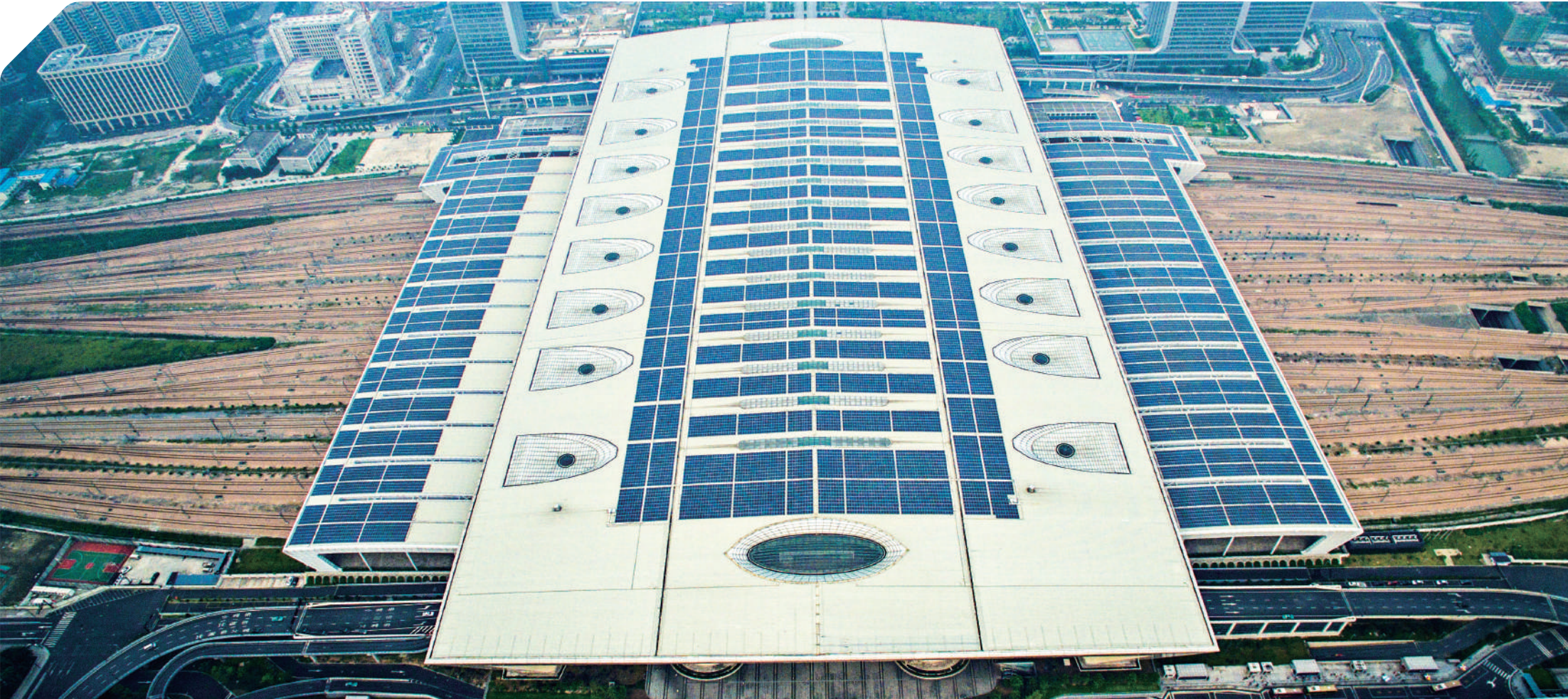
10MW Planta Solar de Telhado da Estação Ferroviária de Hangzhou Leste Hangzhou, Província de Zhejiang, China
