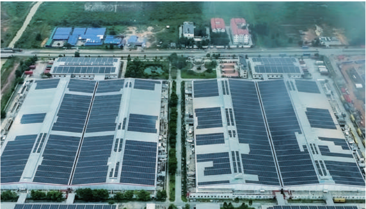
15MW Planta Solar de Geração Distribuída de Telhado D&Y Textile Malásia
