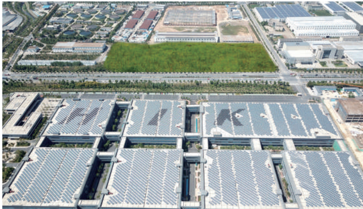
10MW Planta Solar de Telhado da Hikvision Hangzhou, Província de Zhejiang, China
