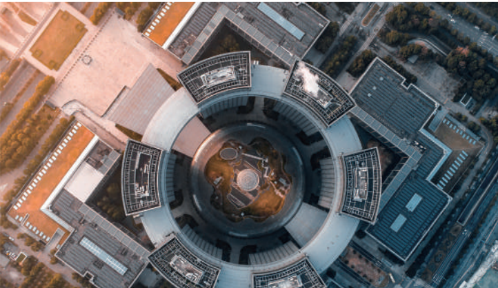
1.2MW Telhado da Sede do Governo Municipal de Hangzhou Hangzhou, Província de Zhejiang, China
